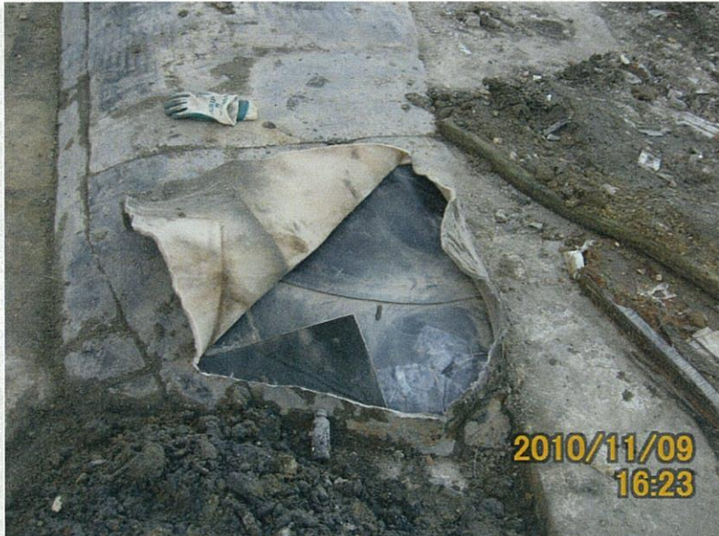
【写真タイトル】②補修 テープによる止水養生
