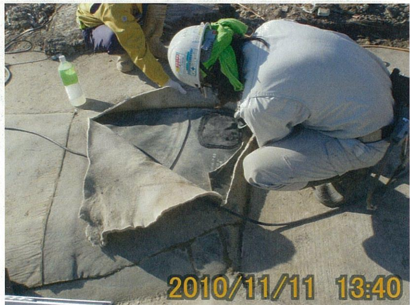
【写真タイトル】⑫融着 面のサンダー仕上げ
