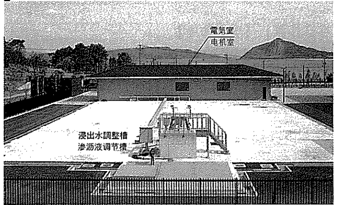
浸出水調整槽・電気室 渗沥液调节槽・电机室
