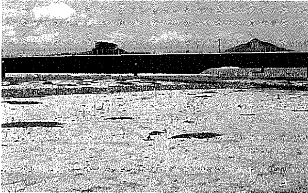
底部遮水シート保護砂 底部防滲膜保护砂
