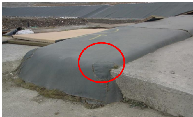
写真-2.1 遮水シート破損箇所の類似箇所
