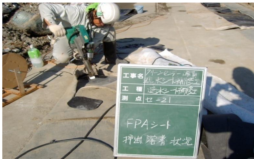
写真-3.1 遮水シートの融着作業
