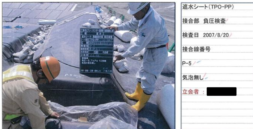
写真-2.4 破損箇所の施工記録写真
