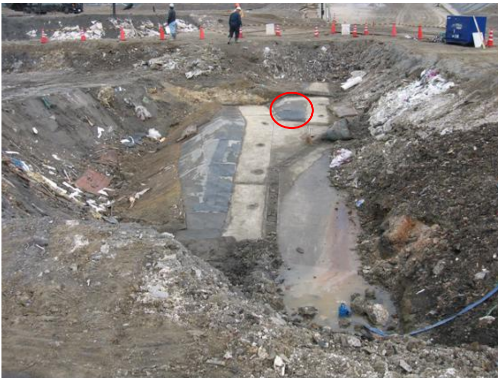
図-3.1 確認調査範囲全景（赤丸印：損傷箇所）
