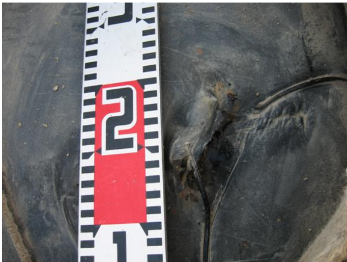
図-2.10 確認調査で特定した損傷箇所(①:L=7cm)
