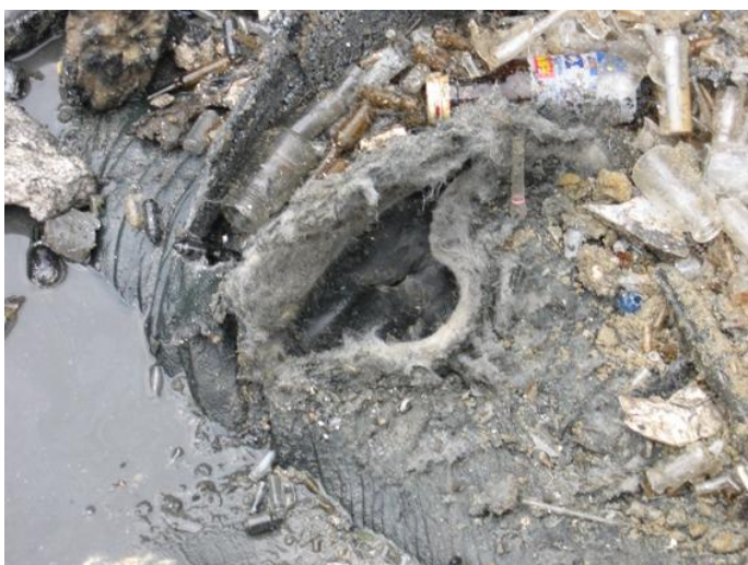
図-2.4 廃棄物掘削作業時に生じた損傷箇所
