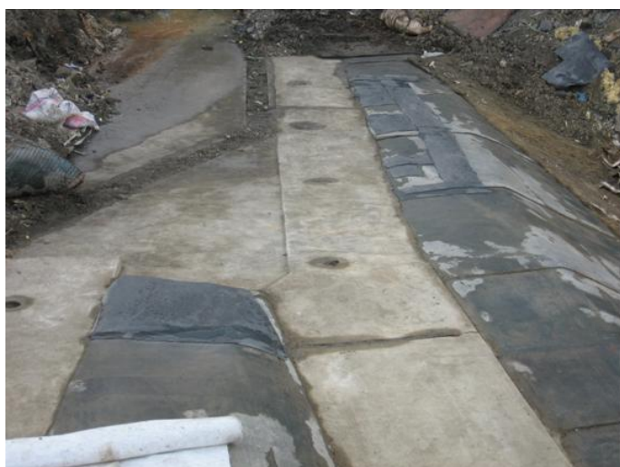
図-2.13 遮水シート補修状況(補修完了)
