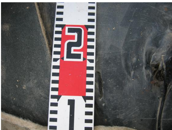
図-2.11 確認調査で特定した損傷箇所(②:L=4cm)
