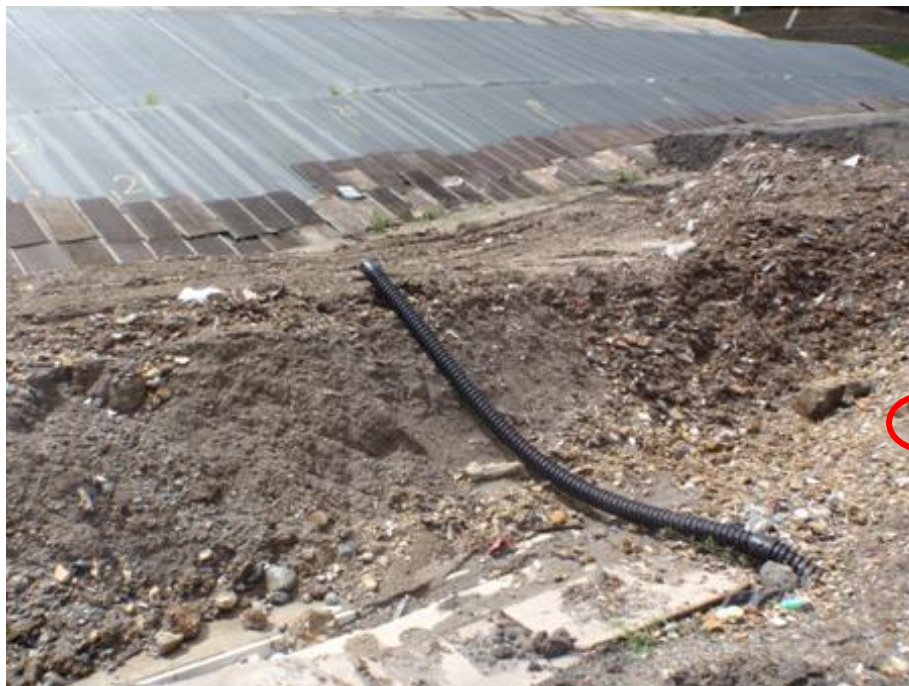
図-1.3 写真1 漏洩異常検知箇所付近(6月16日撮影)
