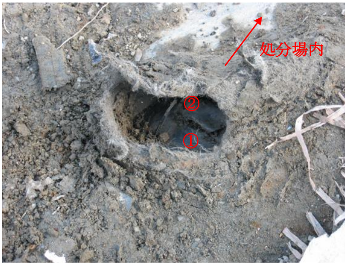
図-2.9 確認調査で特定した損傷箇所(全景)
