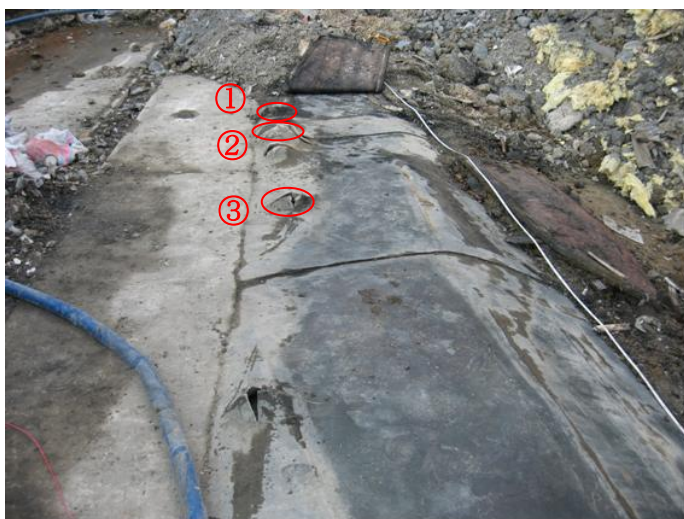
図-2.5 廃棄物掘削作業時に生じた損傷箇所(3箇所:赤丸印)
