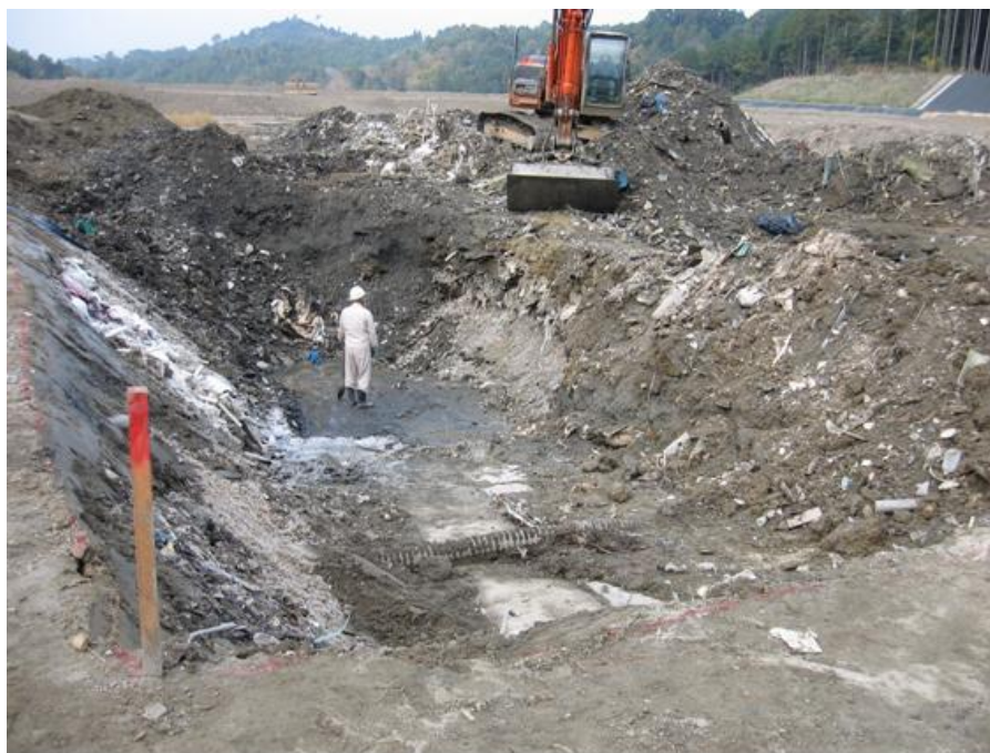
図-2.2 確認調査時の廃棄物掘削状況
