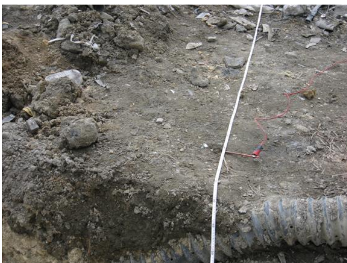
図-2.3 漏洩異常検知箇所確認調査測定状況
