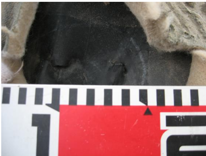
図-2.8 廃棄物掘削作業時に生じた損傷箇所(③:L=3cm、L=1cm)
