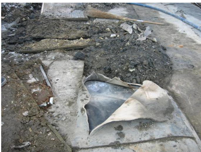
図-2.12 簡易補修状況(絶縁処理)
